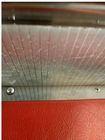
En cours de rectification : vis incorrecte (à G), vis correcte (à D)
