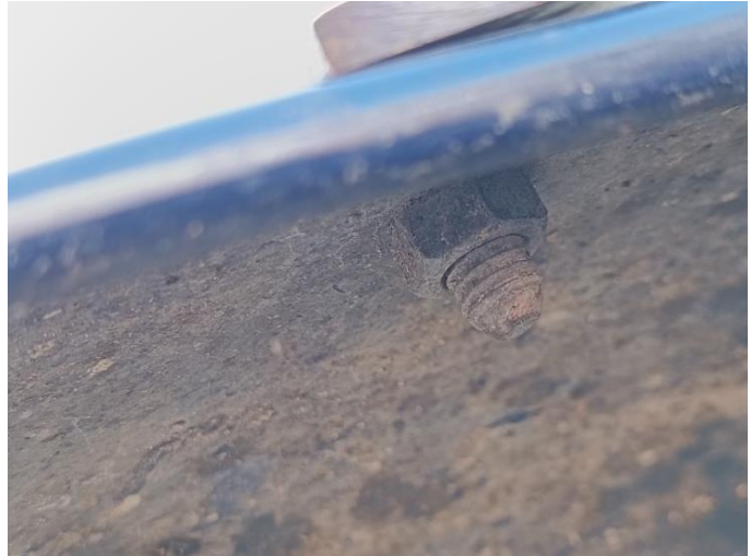
Filetage sous jacent du « rivet » d'aile de la même Bugatti : en fait boulon à tête de vis non fendue. Sanctionner.
