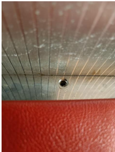
Sous la vis plate: présence d'une cuvette forée dans l'épaisseur du métal
