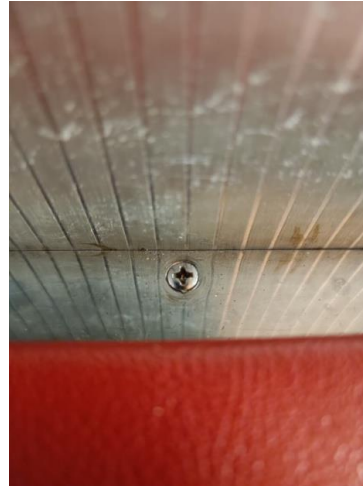
Vis correcte en place: tête petite, fraisée, bombée
